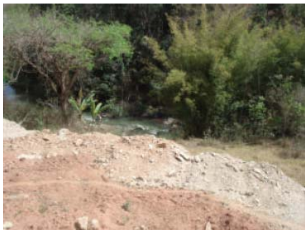
Foto 01. Local do eixo da barragem no Rio Suaçuí Pequeno
