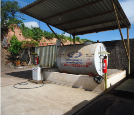
Foto 05. Área de Abastecimento
