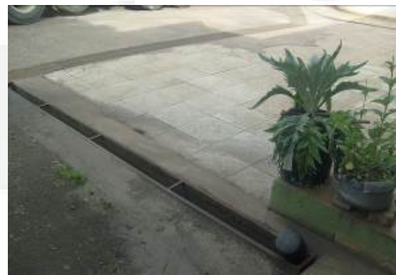
Foto 04. Drenagem de águas pluviais
