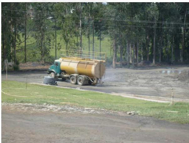
Foto 03. Aspersão das vias internas através de caminhão pipa.
