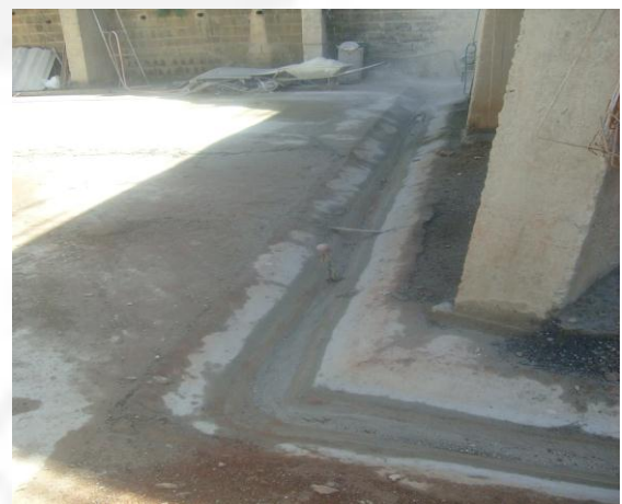
Foto 02. Canaletas no entorno do local da instalação do novo forno.
