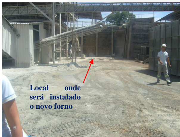
Foto 01. Local onde ocorrerá a ampliação do novo forno
