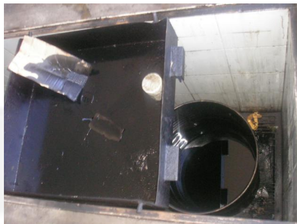
Foto 02. Bandeja coletora de óleo
