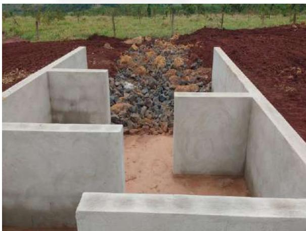
**Foto 03.** Dissipador de energia seguido por enrocamento
