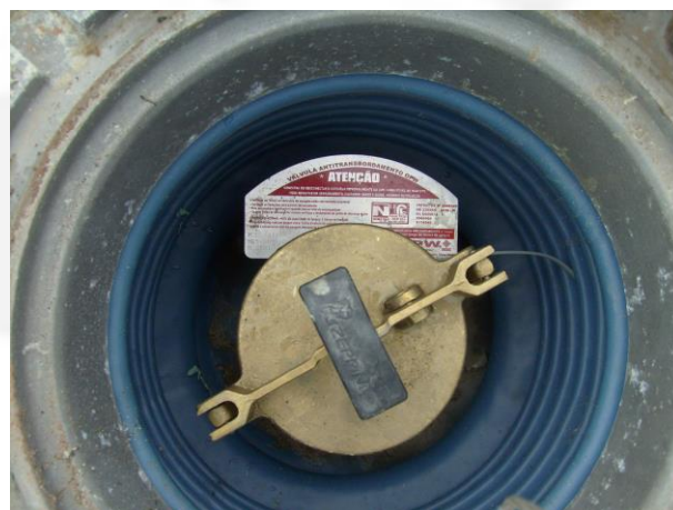
Foto 10. Válvula anti-transbordamento
