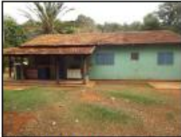
Foto 11: Casa do empreendimento.
