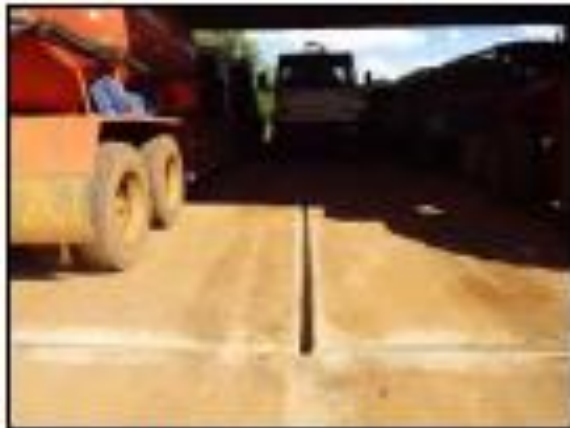
Foto 18: Galpão de máquinas.
