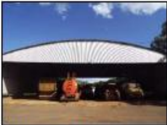
Foto 17: Galpão de máquinas.
