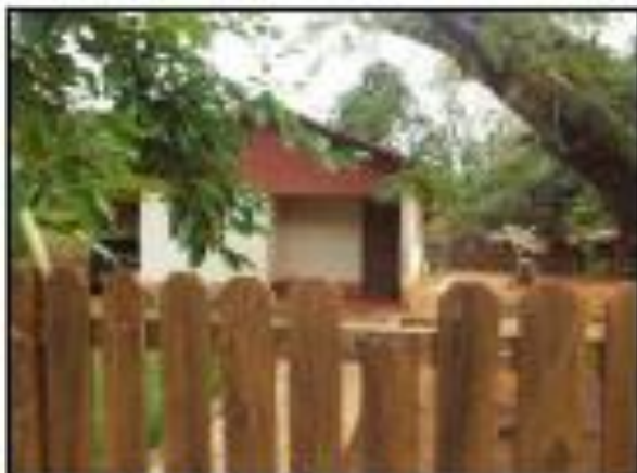
Foto 05: Casa do empreendimento.
