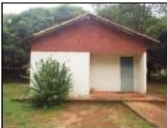
Foto 07: Casa do empreendimento.
