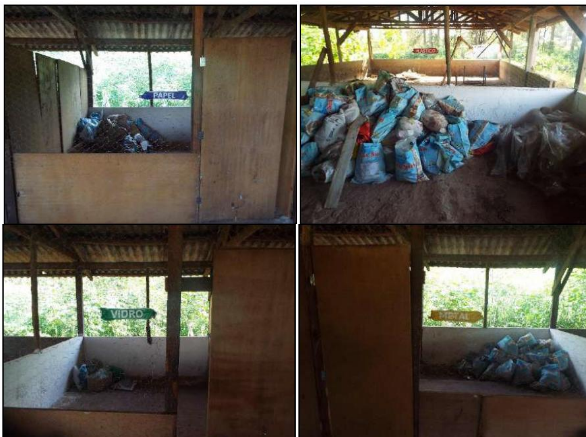
Figura 28: Galpão de armazenamento temporário de resíduos sólidos. Fonte: PCA/Hidroflor, 2019.
