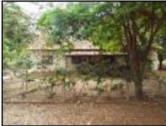
Foto 09: Casa do empreendimento.
