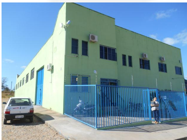
Foto 01. Entrada do empreendimento
