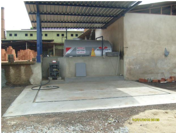
Foto 17: Área de abastecimento.
