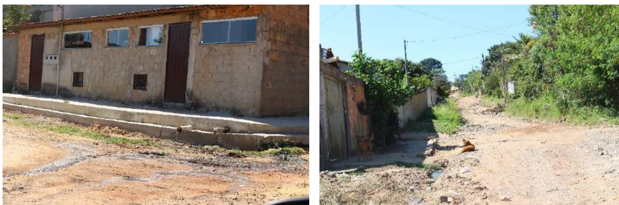
Figura 172 – Áreas subnormais com lançamento de esgoto diretamente em via não pavimentada
