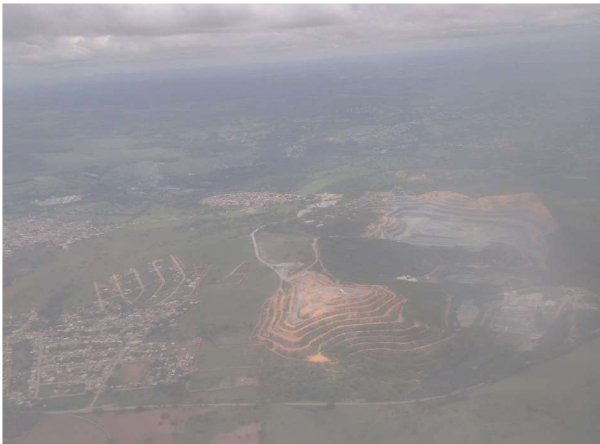
Figura 78 – Exploração de minério na região da APA Vargem das Flores – “Pedreira”
