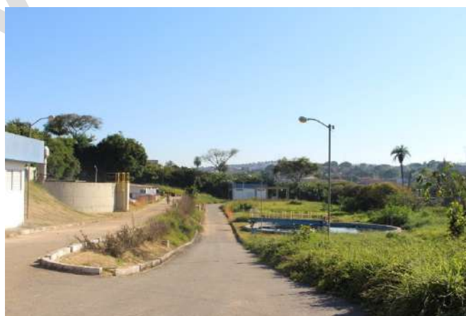
Figura 170 – Vista geral da ETE Nova Contagem
