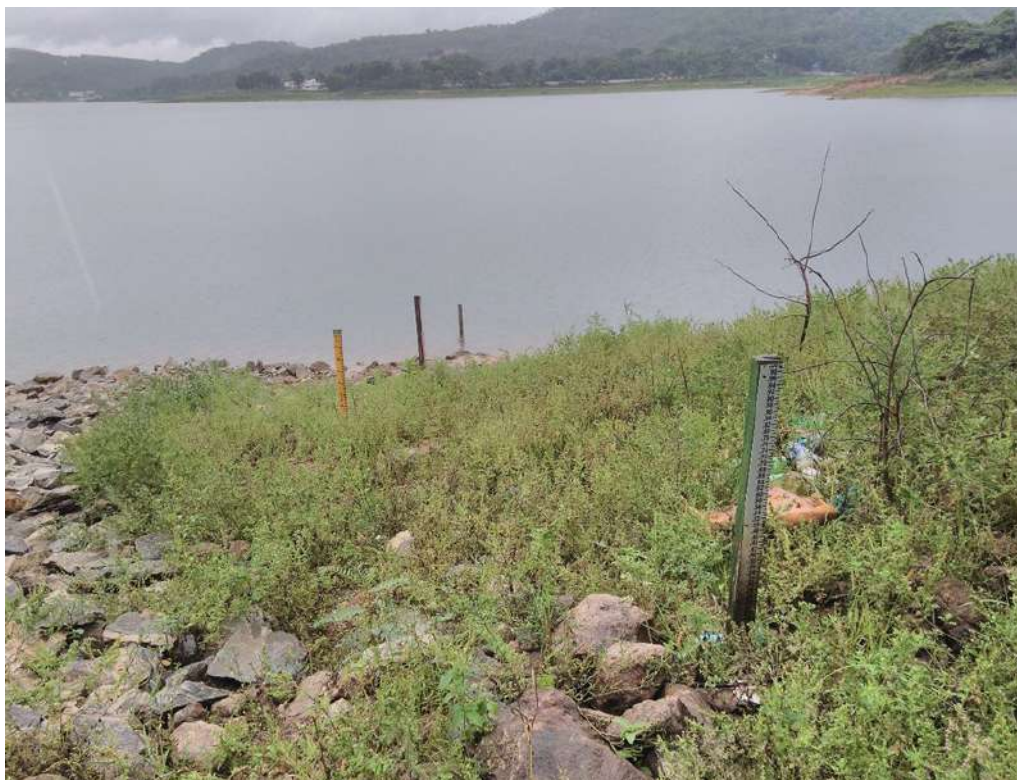
Figura 84 – Conjunto de réguas linimétricas do reservatório Vargem das Flores
