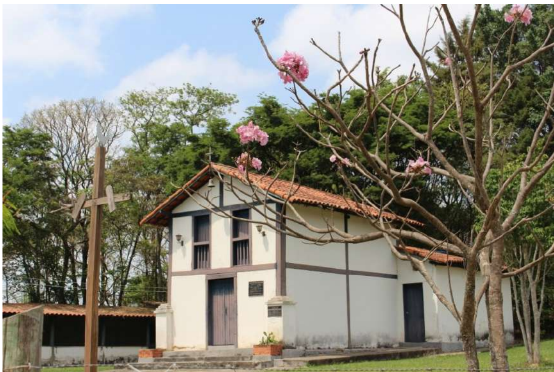
Figura 182 – Igreja de São Sebastião
