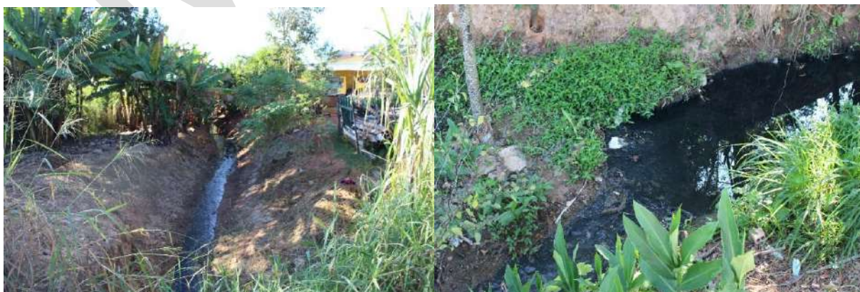
Figura 82 – Vala de lançamento de efluente doméstico
