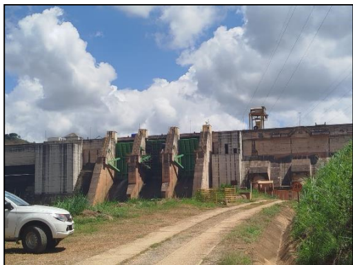
Foto 1: Vista geral do barramento principal
