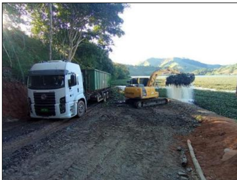
Imagem 15: Processo de remoção das macrófitas aquáticas e carregamento do material no caminhão para transporte até a área de manejo. (Fonte: Programa de Monitoramento de Macrófitas – Id SLA 354818).
