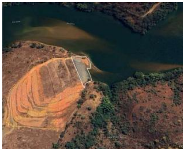
Imagem 8: Intervenção realizada pela Fundação RENOVA no Setor 2. Imagem de 21/08/2024 (Google Earth) - RADA.
