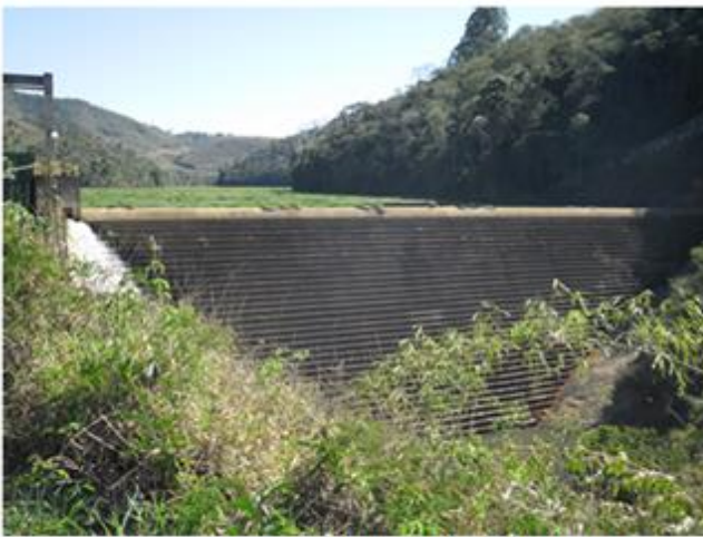
Barragem com vertedouro de Soleira livre
