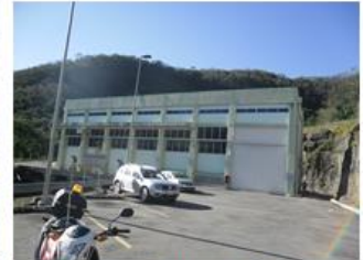
Casa de Força
