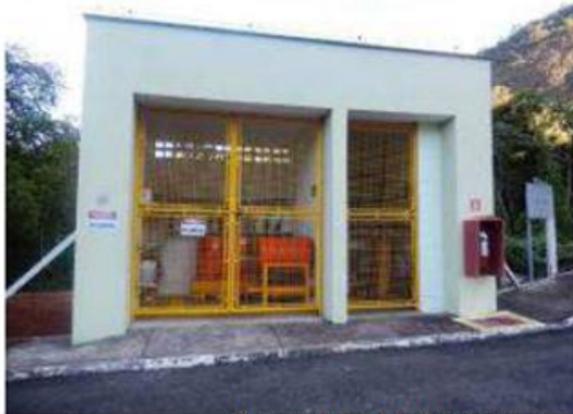
Depósito de Inflamáveis
