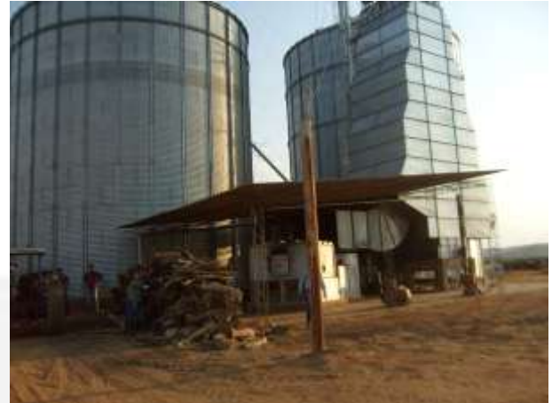
Foto 02. Silos - Armazenagem de 3.900 t
