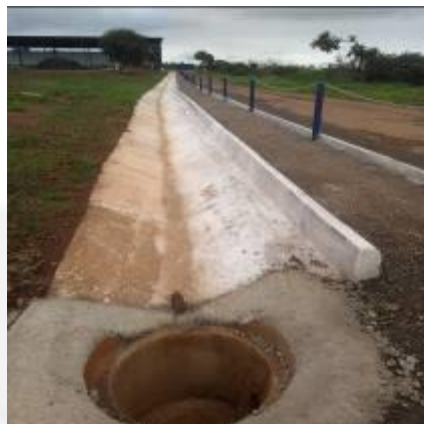
Foto 02. Drenagem de água pluvial
