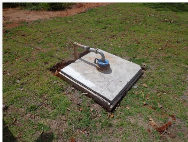
Foto 10. Poço tubular
