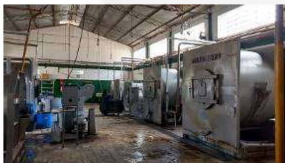
Foto 03. Visão ampla da lavanderia.
