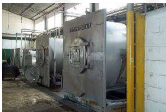
Foto 02. Área de lavanderia.
