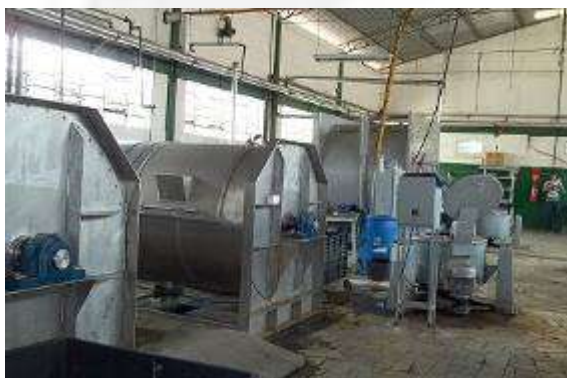
Foto 01. Área de lavanderia.
