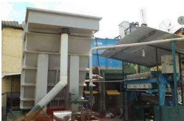
Foto 05. Filtro prensa e reator físico químico.
