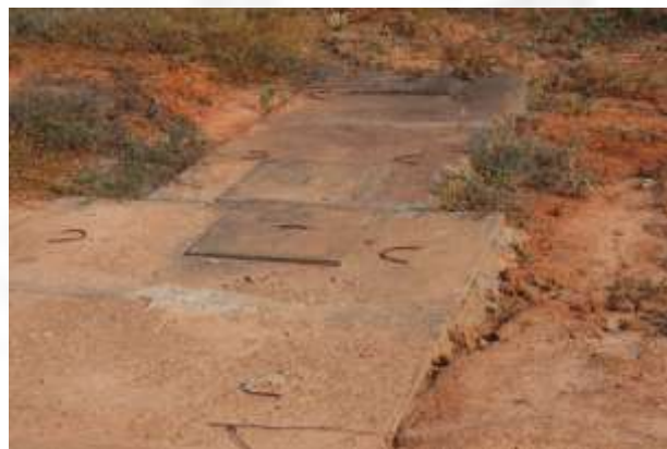
Foto 02. Fossa séptica/filtro/sumidouro.
