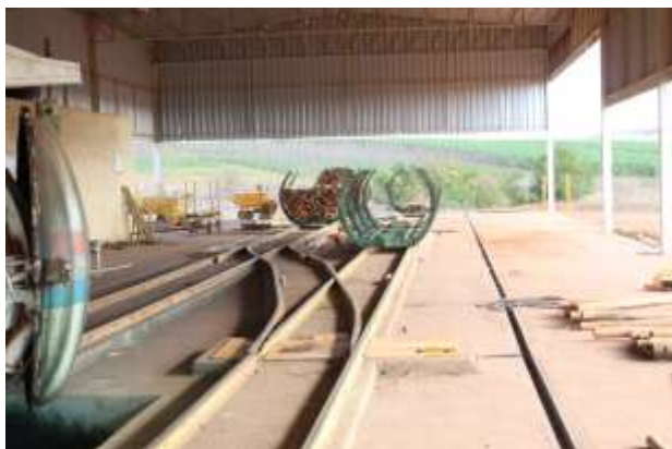
Foto 05. Trilhos da área de tratamento
