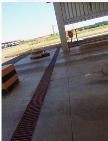
**Foto 03.** Canaletas de direcionamento de efluentes na projeção da cobertura
