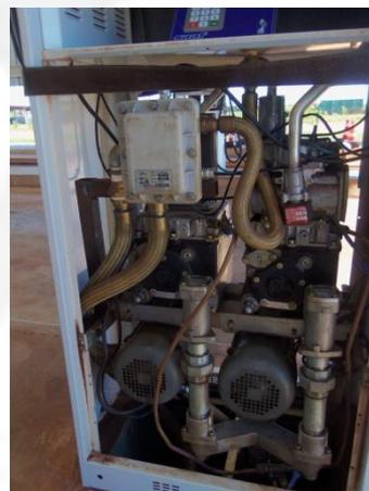
**Foto 02.** Bomba de abastecimento – “sump” e “check valve”
