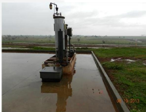
**Foto 04.** Filtro de diesel – “sump” nas conexões e bacia de contenção.
