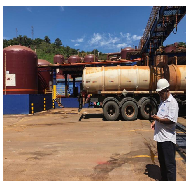
Foto 01. Área de carregamento de produto.
