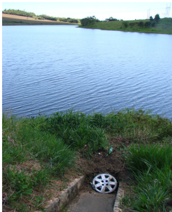
Lixo depositado em drenagem pluvial da rodovia MG 050
