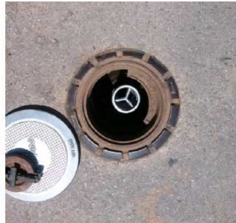
Foto 02 – Boca de descarga
