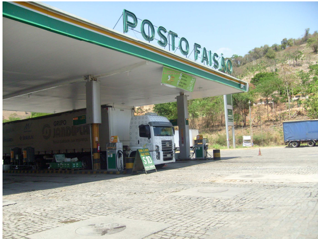
Foto 01 – Vista geral do posto
