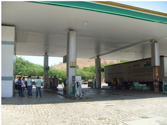
Foto 03 – Vista geral do posto
