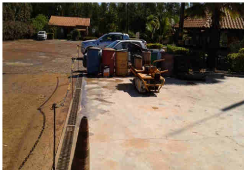
Figura 03. Piso impermeabilizado da oficina
