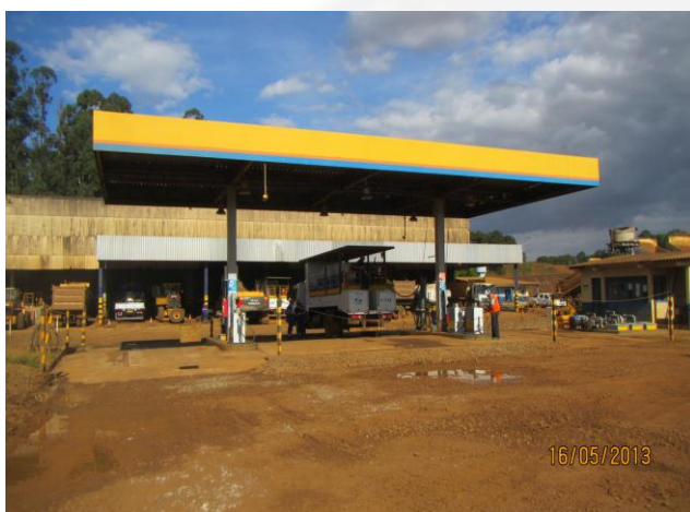
Posto de abastecimento Vale Araxá
