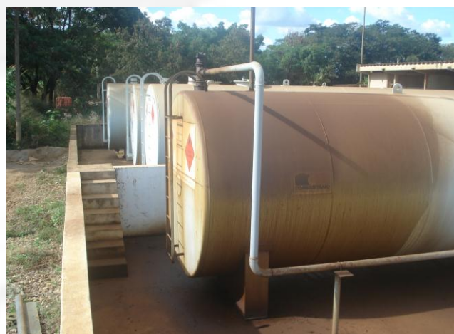
Tanque já existente. Ao fundo tanques novos já instalados
