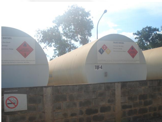
Detalhe dos novos tanques e bacia de contenção.
