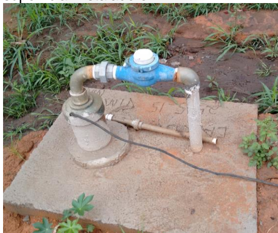
Foto 07. Poço tubular.
