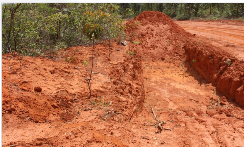
Foto 03: Bacia de contenção e drenagem
