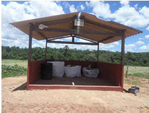
Foto 01. Depósito temporário de RS
