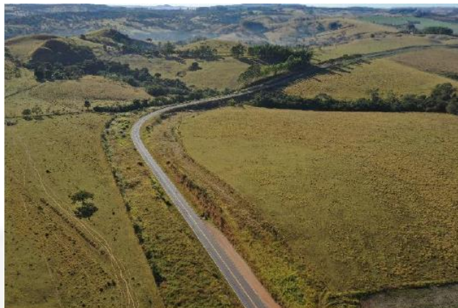
Figura 7: área prevista para a instalação de canteiro de obras e da Subestação Araxá 3. Fonte: Relatório de Vistoria Remota, ISA CTEP, 2021.
