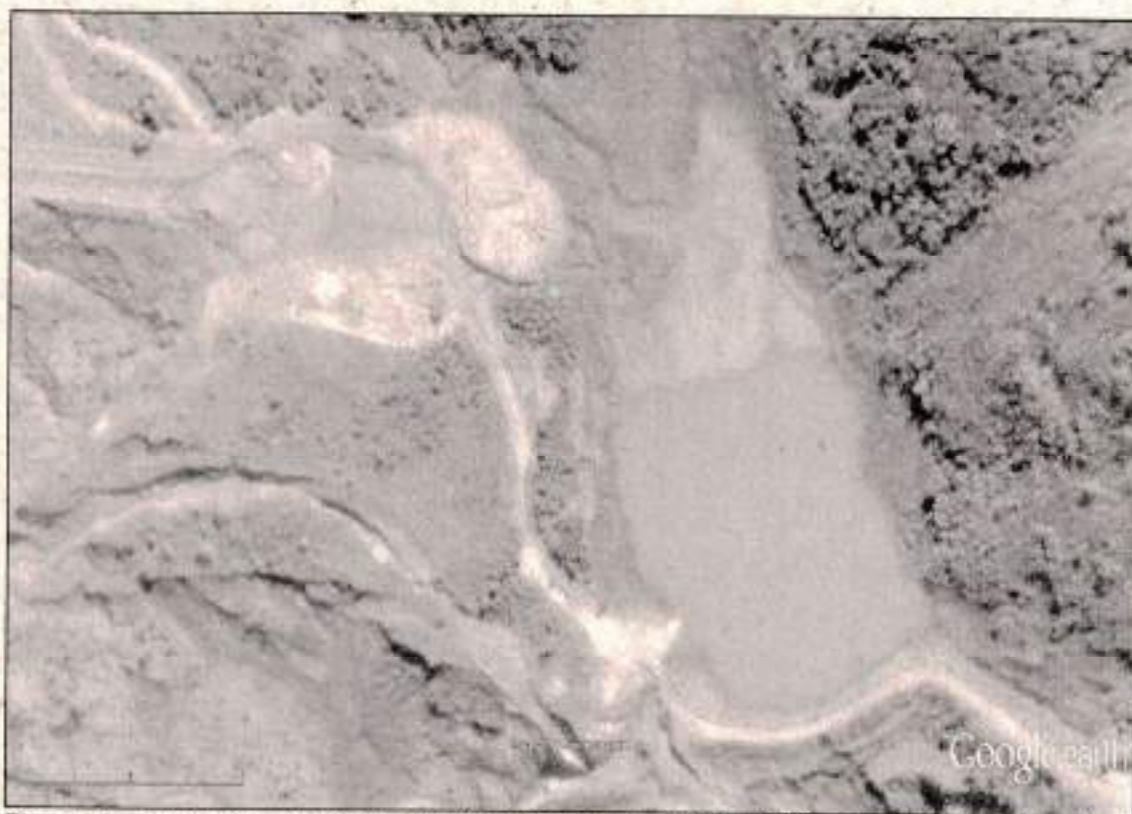
Figura 3 – Vista da Barragem de Captação II em 05/03/2016, com a disposição de resíduos na área de preservação permanente do reservatório
