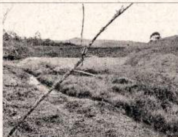
11E. Vista da jusante da barragem "Captação I" mostrando o acúmulo de resíduos/rejeitos à direita (Fonte: Arquivo digital SUPRAM CM).
