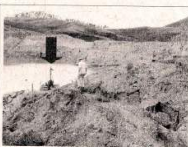
11B. Vista parcial da cava atual. A seta indica a bomba que dragava a água e a lançava sobre a pilha durante a vistoria (Fonte: Arquivo digital SUPRAM CM).
