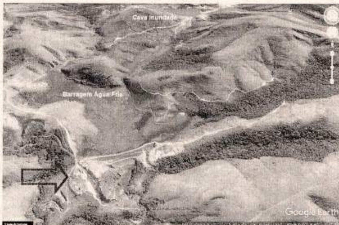
Figura 1. Vista da "Barragem Água Fria" (rejeitos) situada à jusante da cava inundada do empreendimento. A seta indica uma grande erosão (Fonte: Google Earth - Elaboração: SUPRAM CM).
