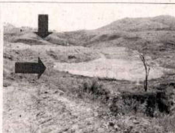
11G. Vista do acúmulo de resíduos/rejeitos à jusante da "Barragem Captação I", indicada pela seta vertical. A seta horizontal indica o local onde estariam sendo executadas obras de reforço da barragem (Fonte: Arquivo digital SUPRAM CM).
