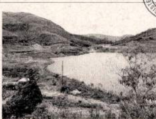
11F. Vista parcial da antiga cava do empreendimento, (situada à jusante da cava mostrada na figura 3A) atualmente inundada. A seta indica a chegada de água carreamento material sólido proveniente da disposição de resíduos/rejeitos mostrada nas figuras 3C, 3D e 3E (Fonte: Arquivo digital SUPRAM CM).
