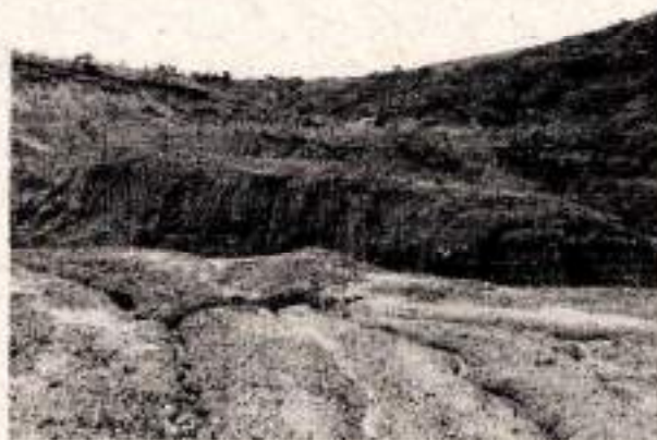
11K. Vista da área onde foram depositados resíduos/rejeitos a montante da Barragem Captação II (Fonte: Arquivo digital SUPRAM CM).
