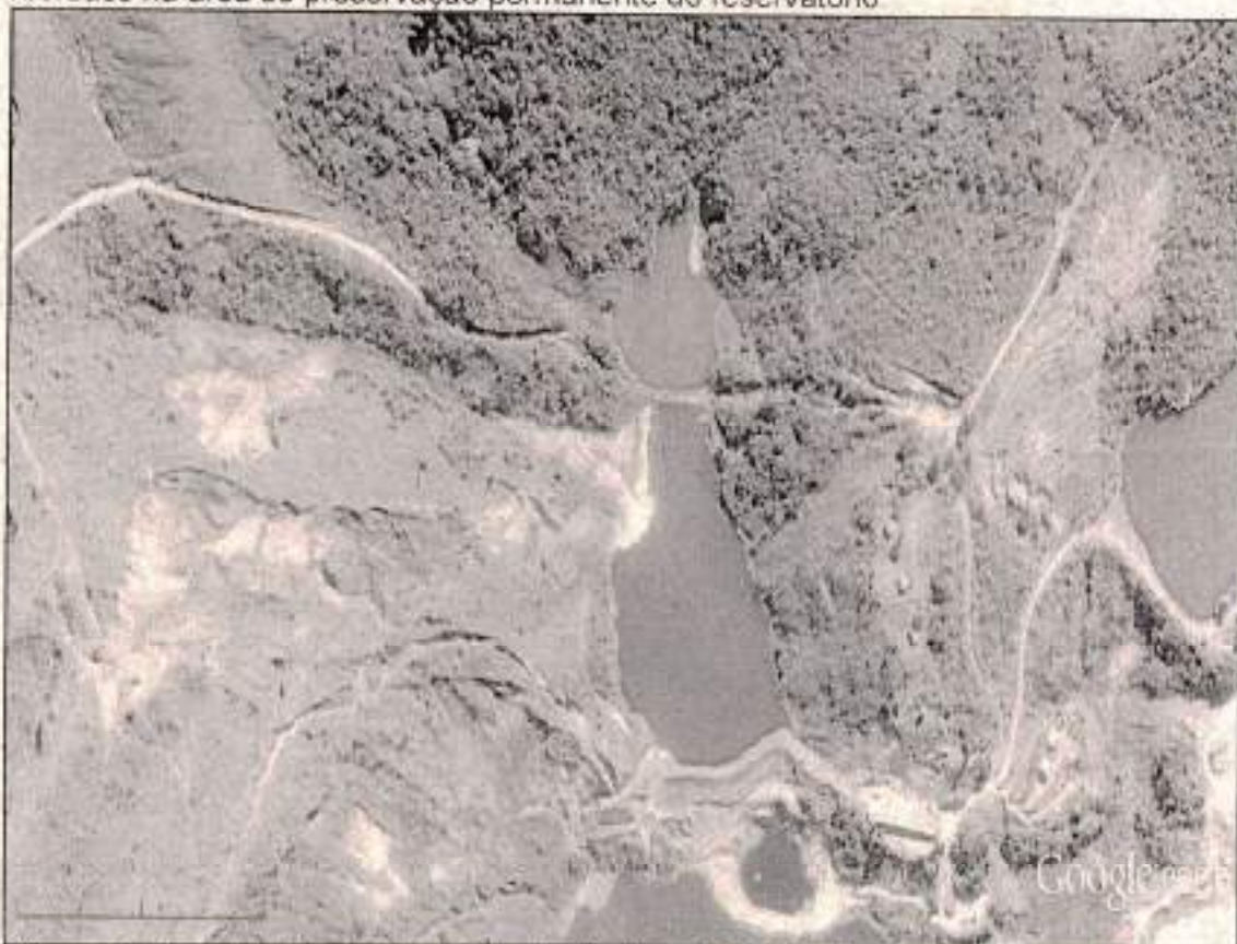
Figura 4 – Vista da Barragem de Captação II em 05/07/2013
