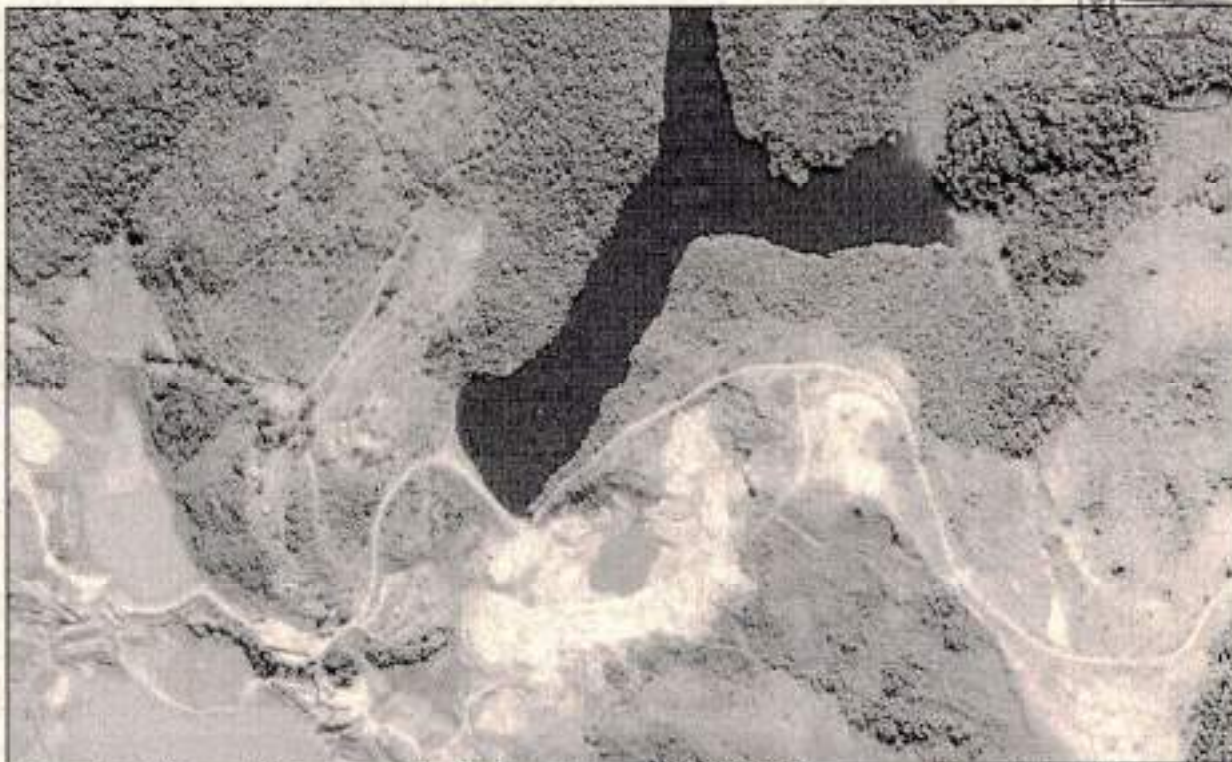
Figura 1 - Vista da Barragem de Captação I em 05/03/2016, com a disposição de resíduos em área de preservação permanente do Córrego Capão.
