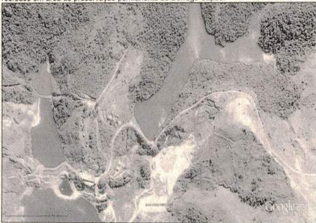
Figura 2 – Vista da Barragem de Captação I em 05/07/2013.
