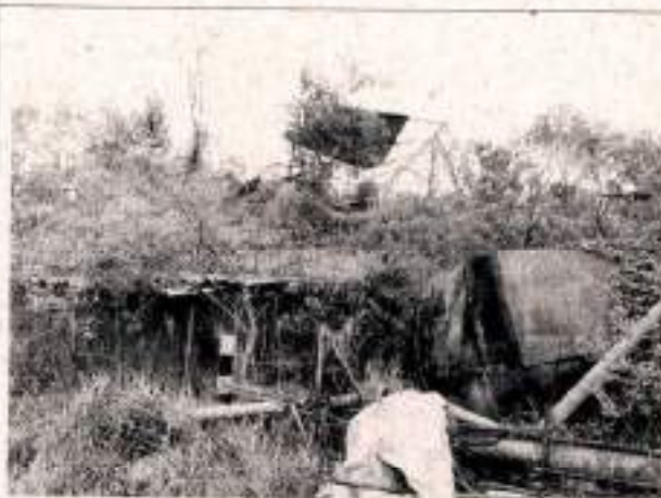
11I. Acúmulo de sucata em APP, à jusante da "Barragem Captação I" (Fonte: Arquivo digital SUPRAM CM).
