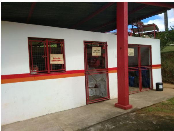
Foto 03: Depósito temporário de resíduos (exterior)
