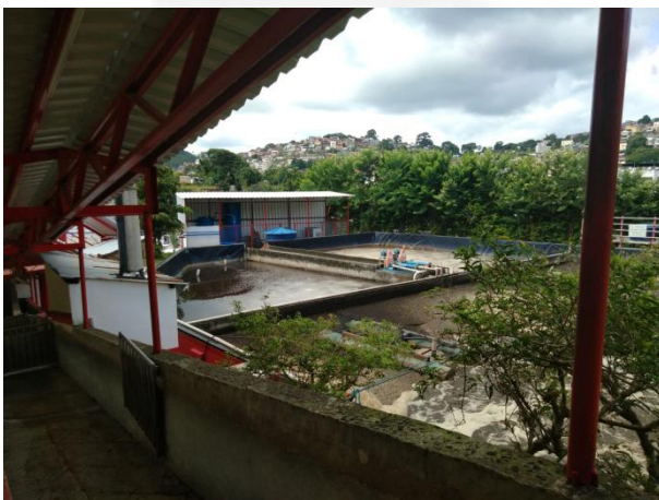
Foto 05: Estação de Tratamento de Efluentes Líquidos
