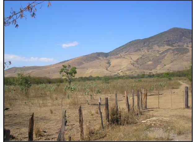
Foto 02: Vista da área da futura ETE.
