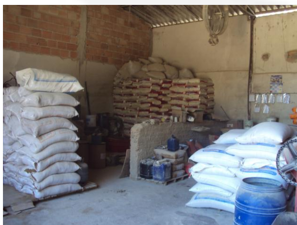
Foto 03. Armazenamento de materiais
