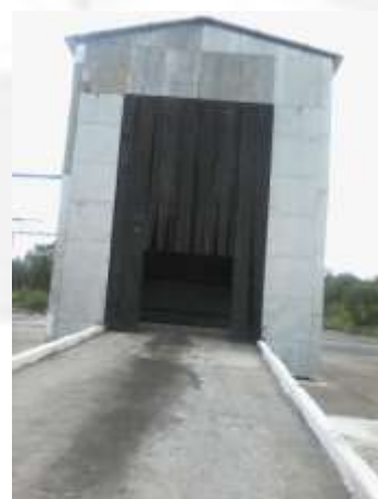
Foto 08. Segundo Sistema de Descarga de Carvão .
