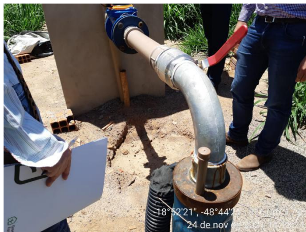
Foto 2. Ponto de captação subterrânea (poço tubular)
