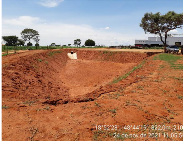
Foto 21. Lagoa em construção
