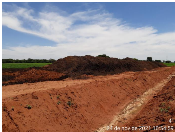
Foto 18. Canal de drenagem do efluente da área de confinamento e área de compostagem ao fundo
