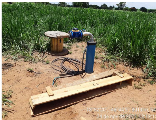
Foto 1. Ponto de captação subterrânea (poço tubular ainda não utilizado)
