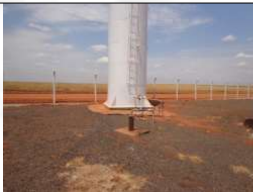
Figura 04. Poço com hidrômetro e horímetro
