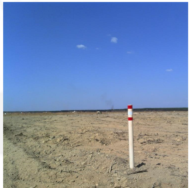
Foto 4: Terraplanagem para instalação da fábrica
