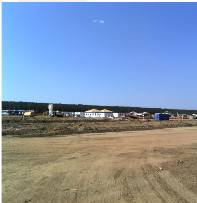
Foto 3: Canteiro de obras
