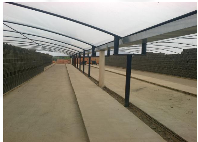
Foto 04. Detalhe para as calhas (sistema de drenagem pluvial)
