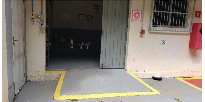
Depósito de Produtos e Resíduos Perigosos
