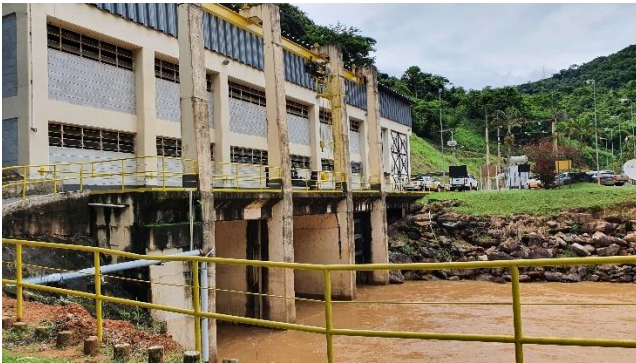
Canal de Fuga
