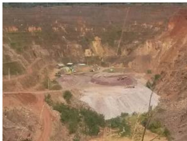
Foto 02. Visão geral do empreendimento
