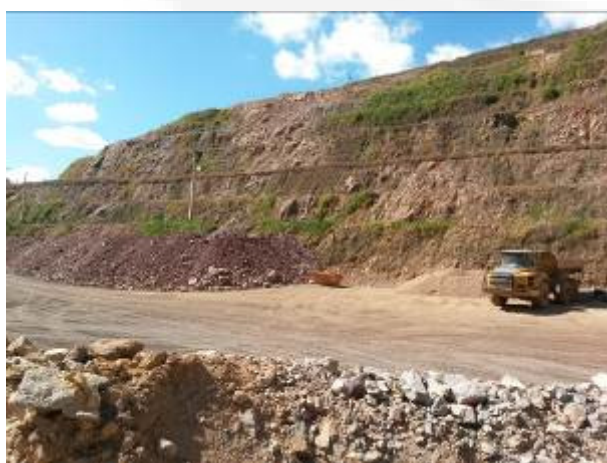
Foto 03. Retaludamento e revegetação previstos no PRAD
