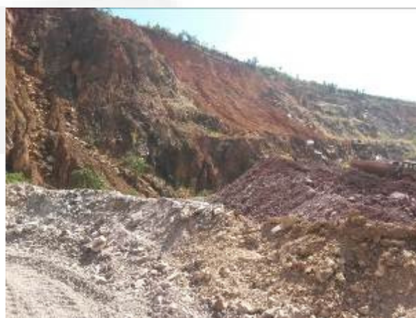
Foto 04. Área em processo de retaludamento
