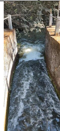
Figura 4: Ponto de retorno da água ao Rio Abaeté após passar pela casa de força.
