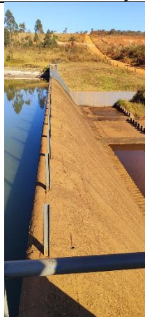
Figura 3: Vertedouro da CGH.
