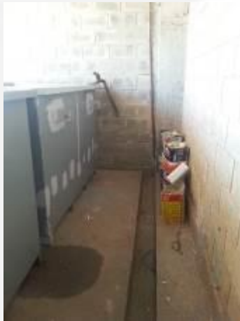
Depósito de resíduos - detalhe
