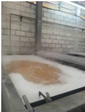
Tanque de banho - pintura
