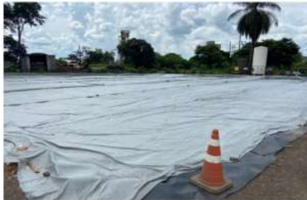
Foto 04. Pátio de sucata mista impermeabilizado. Fonte:RCA
