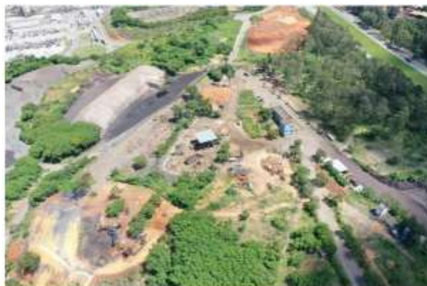
Foto 03. Imagem aérea do empreendimento. Fonte:RCA
