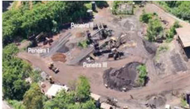
Foto 01. Imagem aérea das Peneiras I, II e III. Fonte:RCA
