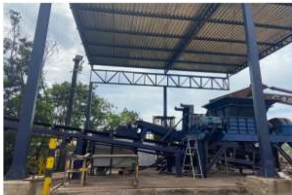
Foto 06. Galpão de prensagem. Fonte:RCA
