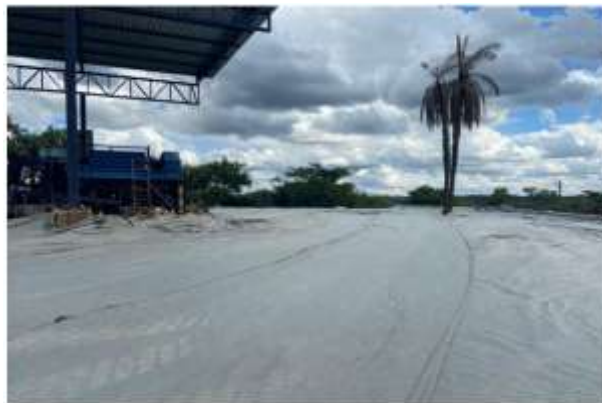
Foto 05. Pátio de sucata pesada impermeabilizado. Fonte:RCA
