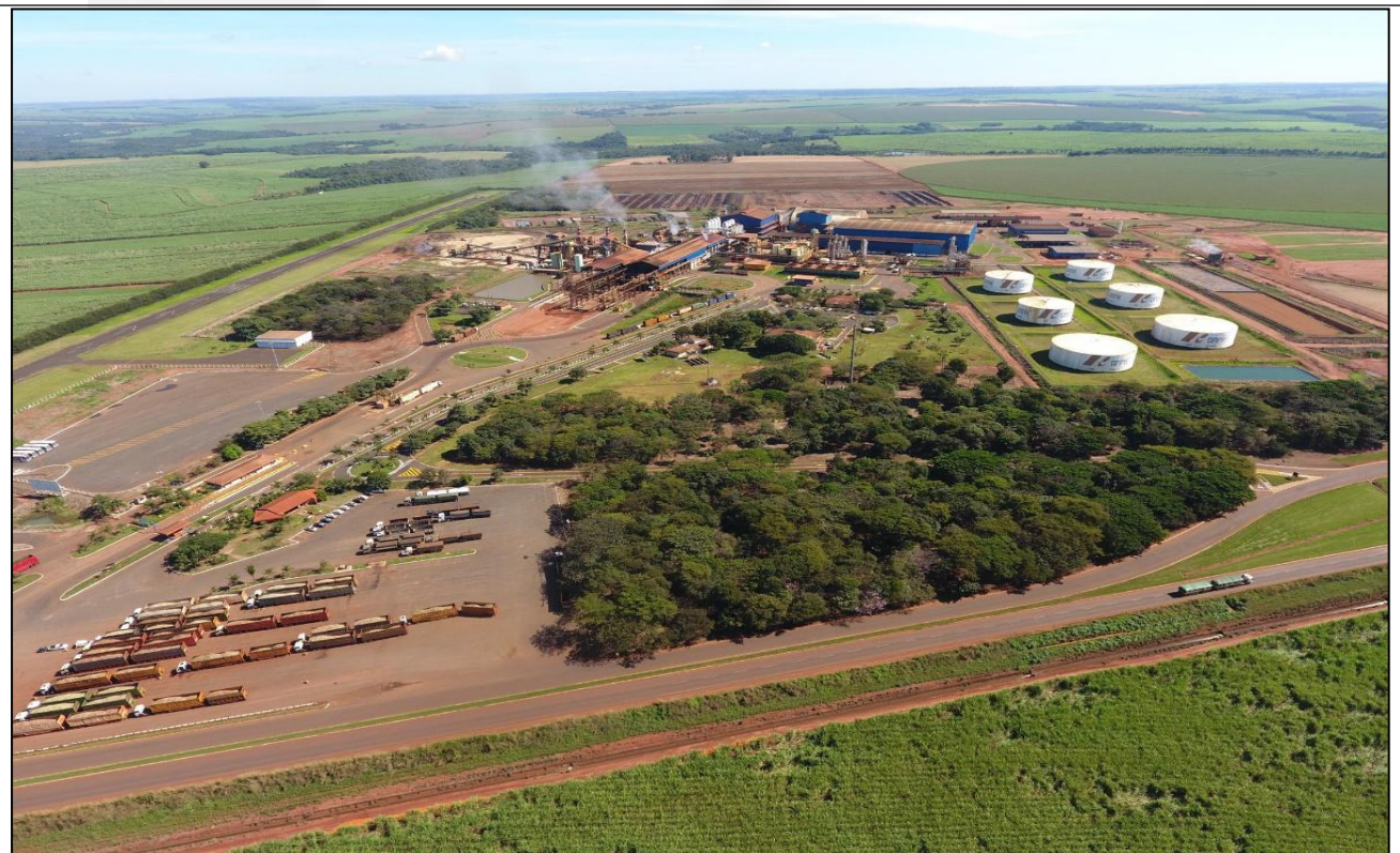
Visão Geral da Usina Coruripe Filial Campo Florido. Foto: Usina Coruripe, 2021
