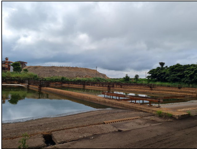
Tanques de decantação. Fonte: Coruripe, 2021
