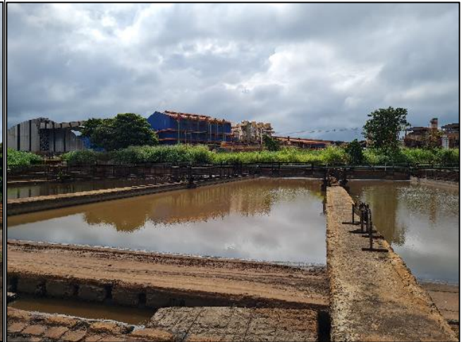
Tanques de decantação. Fonte: Coruripe 2021
