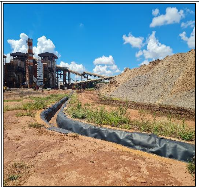
Canaletas impermeabilizadas com PEAD.
