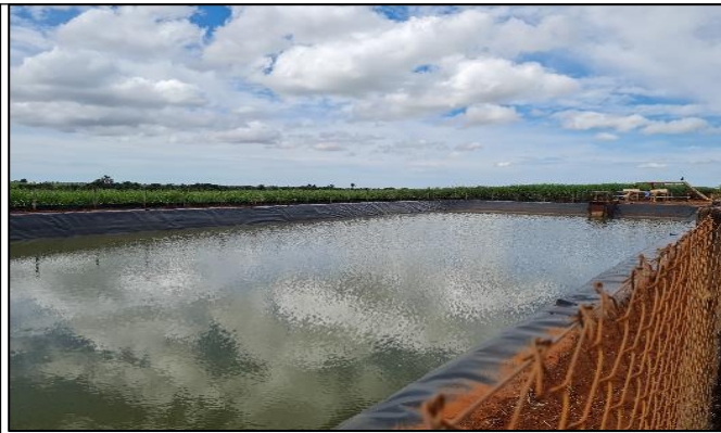
Reservatório de vinhaça. Fonte: Coruripe, 2021
