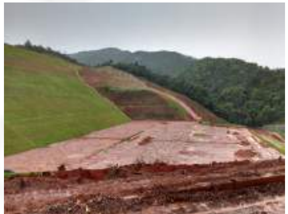
Foto 02. Maciço, vertedouro e instalação de drenos.
