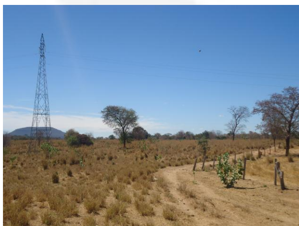
Foto 03. Linha de Transmissão de Energia dentro da propriedade
