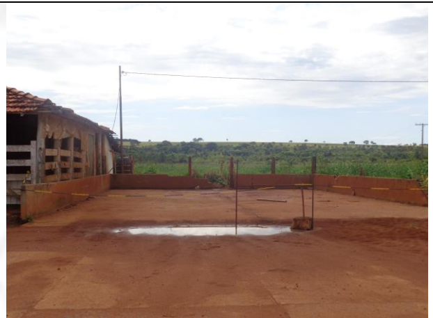
Figura 08. Lavador de veículos desativado
