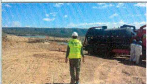
Bacia de contenção dos efluentes
