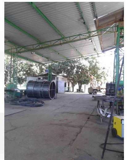
Foto 3: Oficina de manutenção de máquinas
