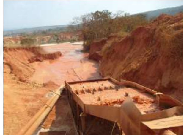
Imagem 09: Dispositivo para dissipação de energia antes da bacia de decantação.
