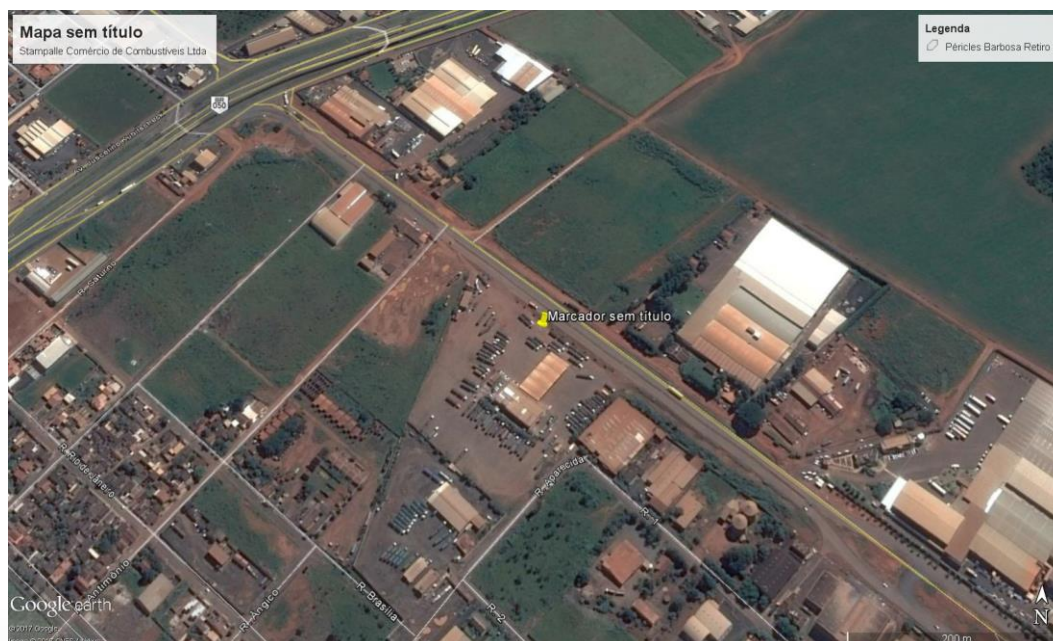
Vista do Posto Stampalle Comércio de Combustíveis Ltda. - Fonte Google Earth
