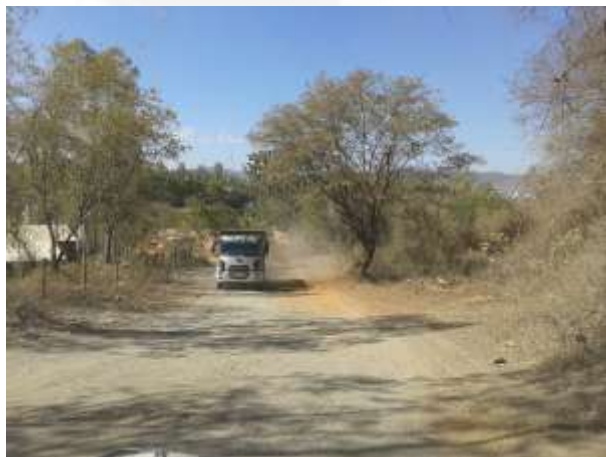
Foto 19: Vias de acesso sem aspersão (20/07/2015).
