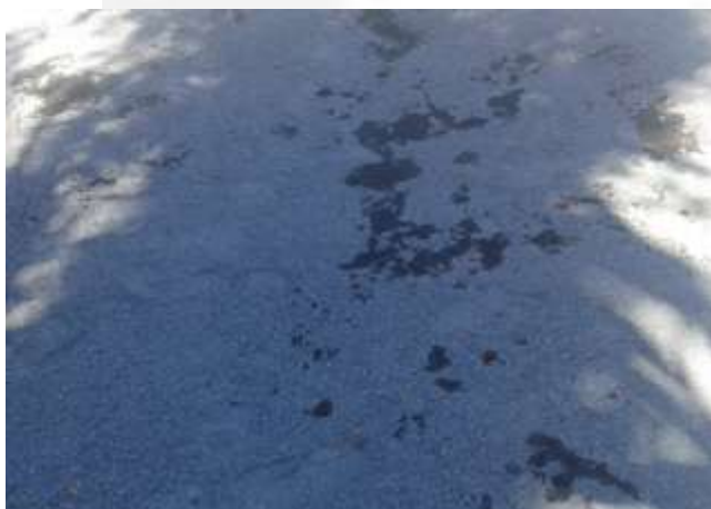
Foto 9. Óleo derramado no pátio de veículos e máquinas (20/07/2015).
