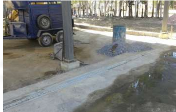
Foto 5. Oficina de veículos e máquinas em obras (20/07/2015).
